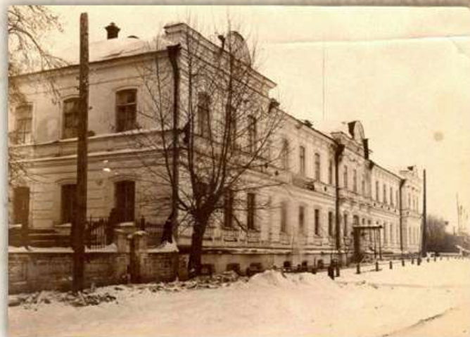
Здание Кунгурского машиностроительного техникума, 1927 г. Р-1001, оп.1, д.6751
