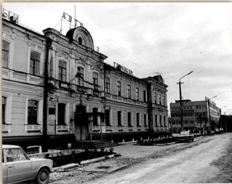
Общий вид здания Кунгурского автотранспортного техникума, 1980-е гг. Р-1001, оп.1, д.6802
