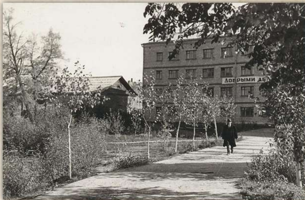
Вид здания общежития автомеханического техникума, 1970 г. Р-1001, оп.1, д.148
